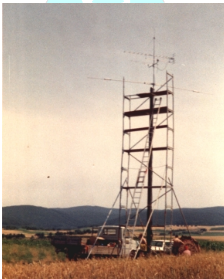
Der Antennenbau Nr.3 auf der OV-Wiese
