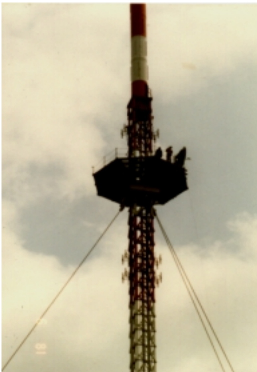
Der Antennenbautrupp auf der oberen Plattform des Mastes
