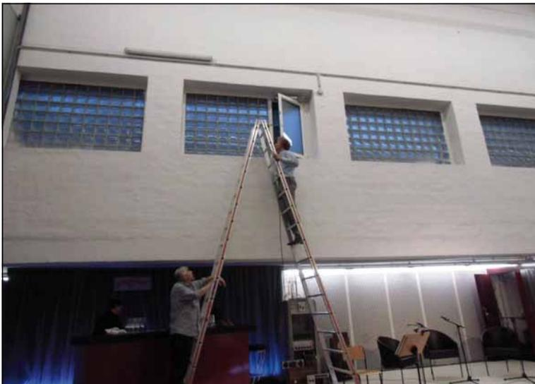
Bild 2: Die Verlegung des Koaxkabels für die  $\frac{5}{8}$ -Lambda-Vertikalantenne
